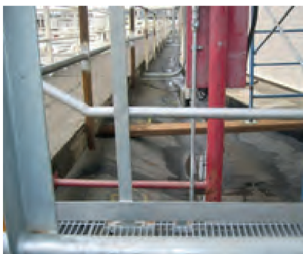
▲ Accesos y obstáculos existentes.
