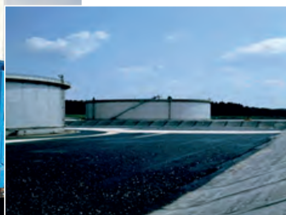
En la refinería Total de La Mède Francia ▲ se vertió asfalto directamente sobre el Coletanche para proporcionar una superficie de conducción a equipos pesados.
