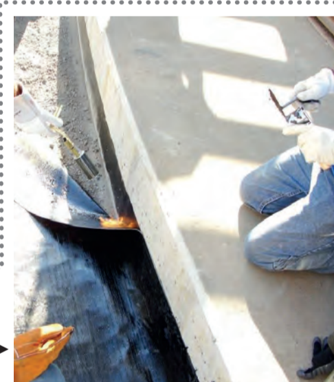
Encuentro del Coletanche con el soporte de hormigón del tanque. ►
