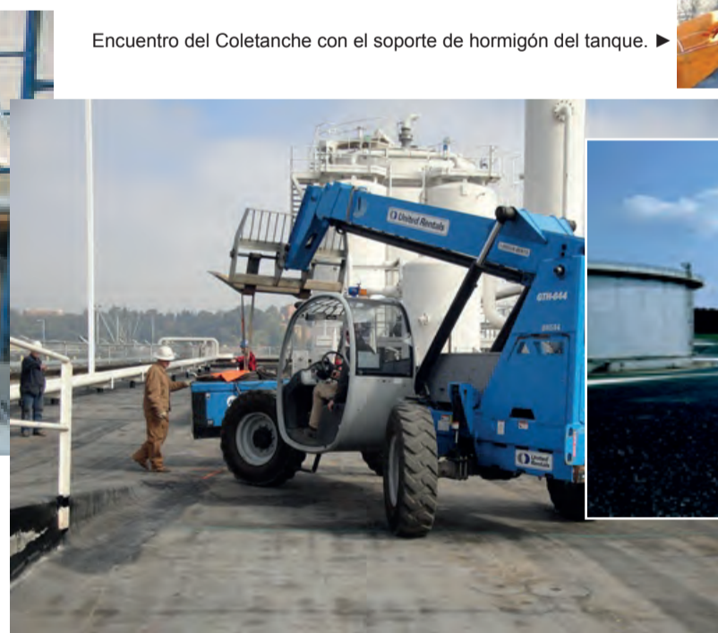
En la refinería Total de La Mède Francia ▲ se vertió asfalto directamente sobre el Coletanche para proporcionar una superficie de conducción a equipos pesados.
