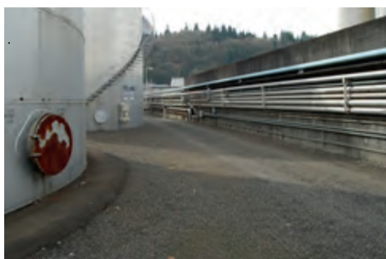
► Terminal antes de empezar el proyecto.
