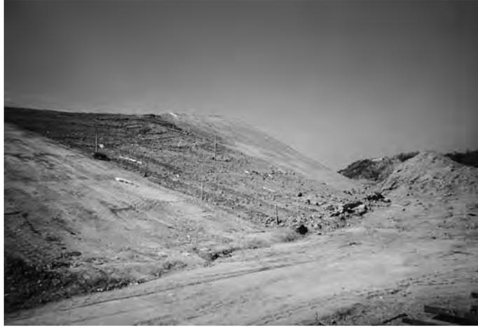
Photo 5 Préparation du support, noter la qualité en phase 3 prêt à recevoir le géotextile / *Preparation of the support, to note quality in phase 3 ready for receiving geomembrane.*
