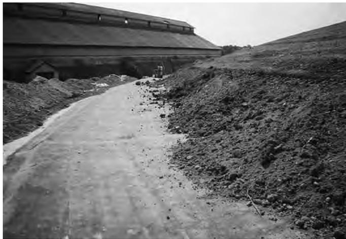
Photo 6 Couverture par terre directement sur la membrane bitumineuse / *Capping by ground directly on the bituminous membrane.*
