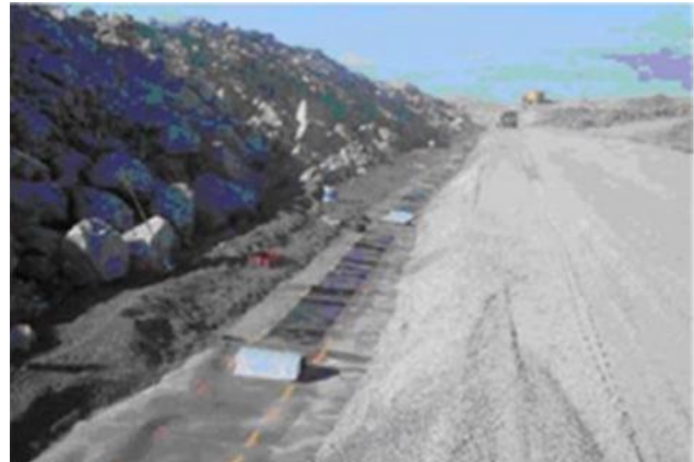
Figura 8: Flam Stick pegado al HDPE
