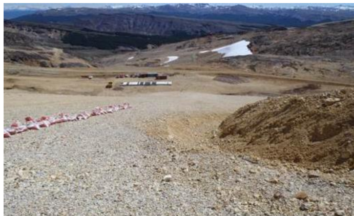
Figura 7 Soporte para la geomembrana bituminosa (ver el tamaño de las partículas)
