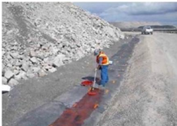
Figura 8: Aplicación de la imprimación sobre HDPE
