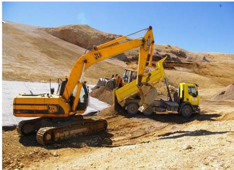
Figura 9: Instalación de recubrimiento de arena y grava.
