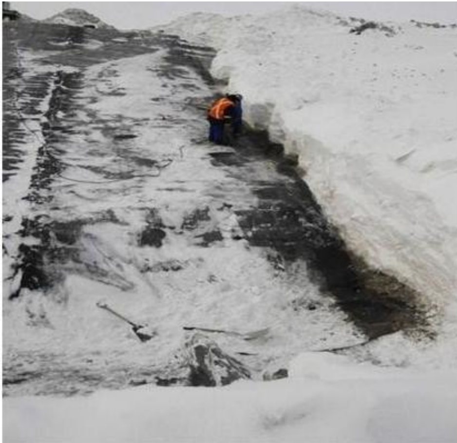
Figura 4: Evacuación de nieve durante la instalación de liner de geomembrana bituminosa en la balsa 2
