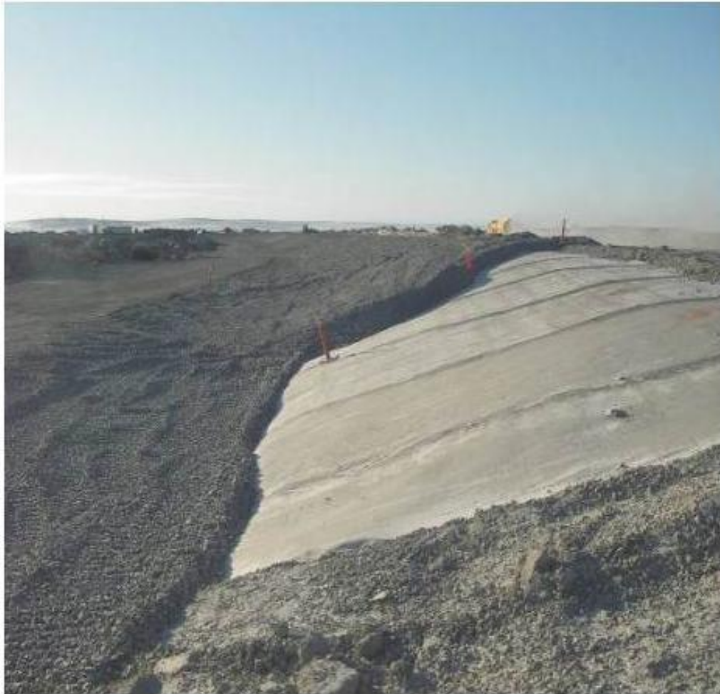
Figura 3: Liner de Geomembrana Bituminosa expuesta a la intemperie a largo plazo para evaluación
