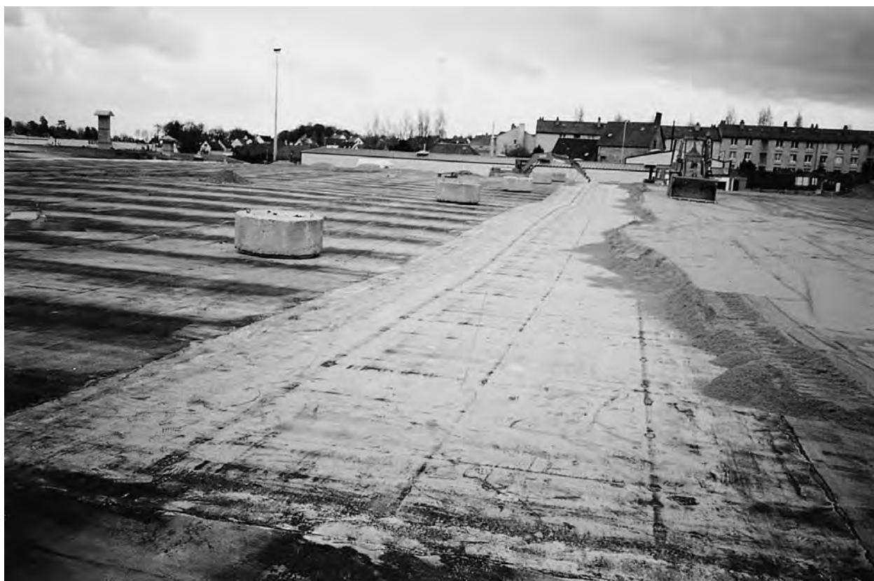
Photo 4 Préparation de la couverture végétalisable / Preparation of the cap
