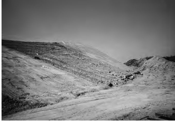
Photo 5 Préparation du support, noter la qualité en phase 3 prêt à recevoir le géotextile / Preparation of the support, to note quality in phase 3 ready for receiving geomembrane.
