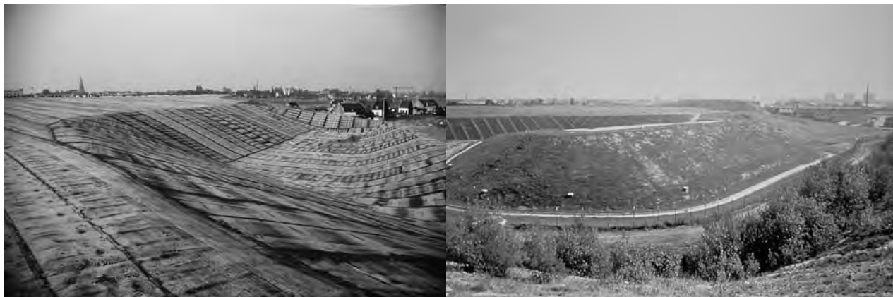
Photos 2 et 3 Couverture de charrées issues du traitement de minerai de chrome / Coverage of wastes coming from the treatment of ore of chromium
