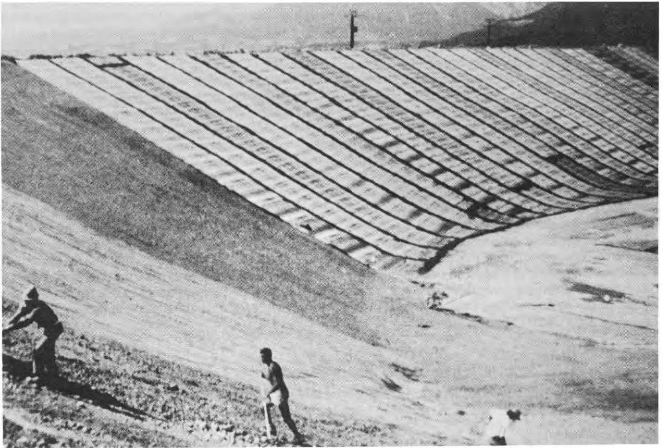
Préparation de la couche support / Preparation of support layer
