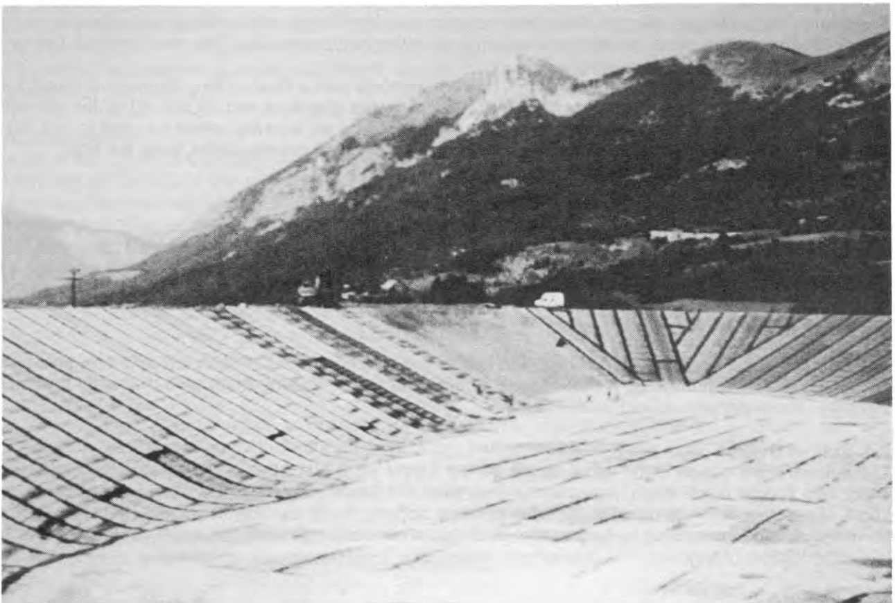
Vue générale du réservoir / General view of water storage reservoir
