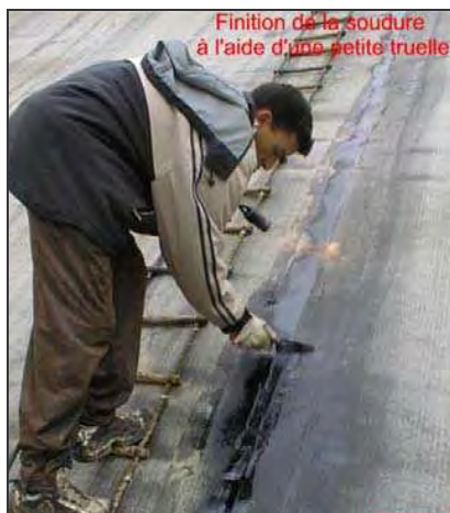
Endausführung der Schweißnaht mit der Kelle
