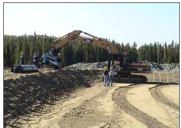
Verteilung der Rollen nahe am Verlegeort, damit sie vom Bagger aufgenommen werden können
