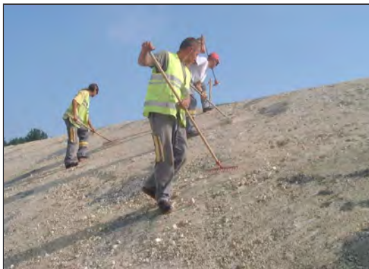
Reinigen der Oberfläche des Untergrunds mit dem Rechen
