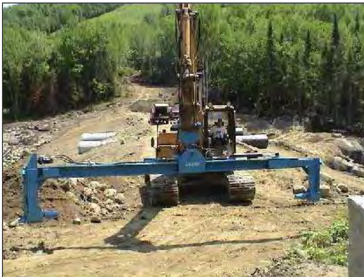
Auf dem Bagger montierter Hydraulikträger
