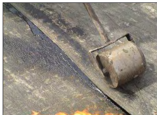
Andrücken: Überlaufen von Bitumen
