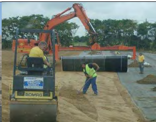
Versetzt arbeitender Bagger, um die Ausbesserung des Untergrunds direkt vor der Verlegung der Geomembrane zu ermöglichen.
