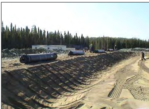
Verteilung der Rollen nahe am Verlegeort, damit sie vom Bagger aufgenommen werden können
