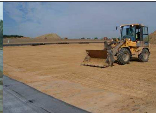
Ebnen der Untergrundfläche mit dem Lader
