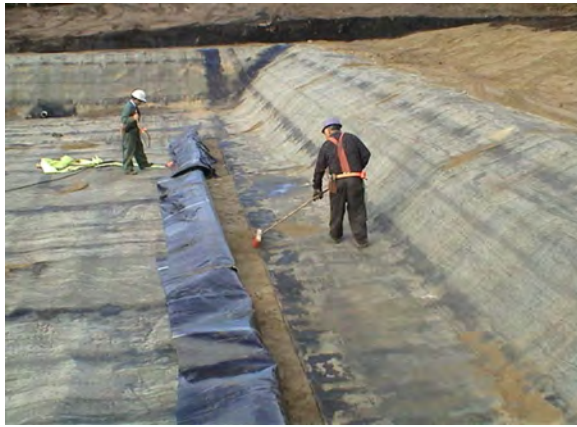
Limpieza de las juntas
