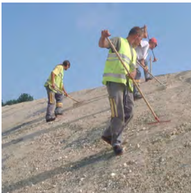
Limpieza con el rastrillo de la superficie del soporte
