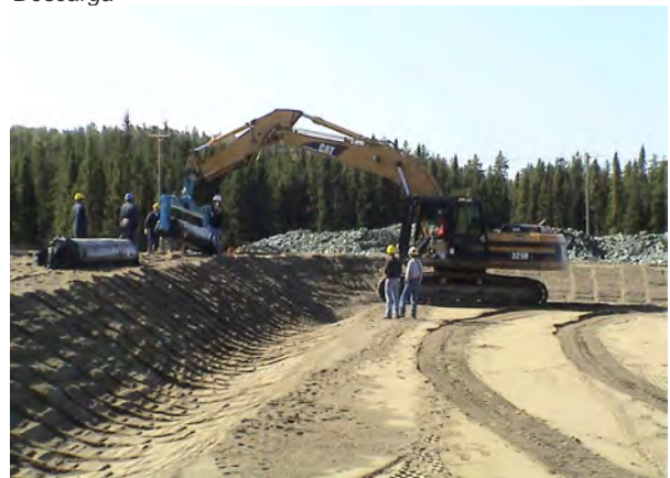
Distribución de los rollos cerca del sitio de puesta de manera que la excavadora pueda tomarlos.
