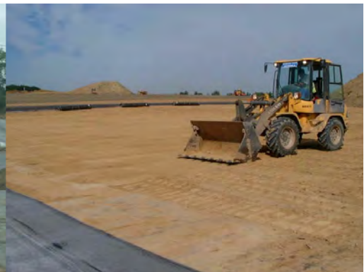
Aplanando la superficie del soporte
