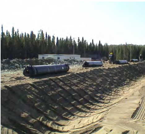
Distribución de los rollos cerca del sitio de puesta de manera que la excavadora pueda tomarlos.
