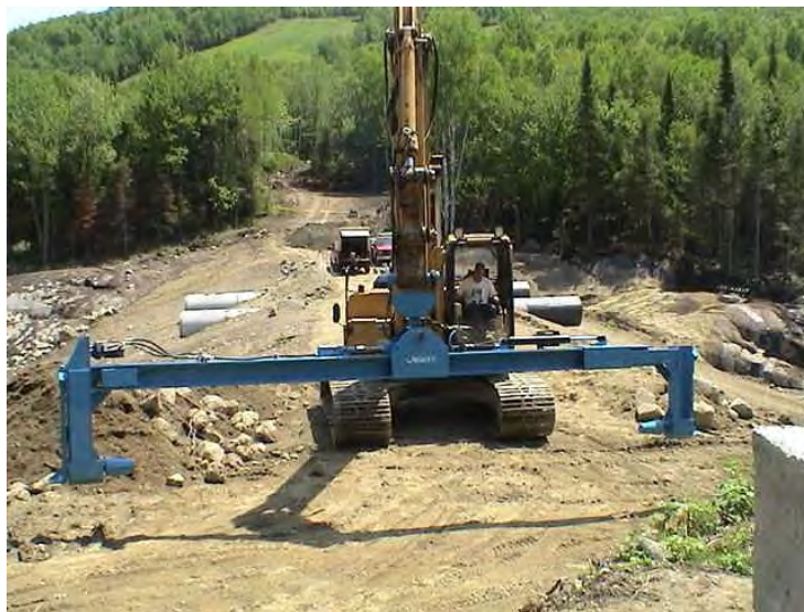
Viga hidráulica montada sobre la excavadora.
