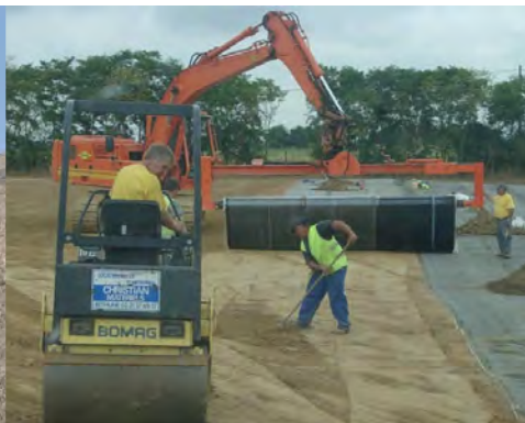
Excavadora trabajando permitiendo la mejora del soporte justo antes de la puesta de la geomembrana
