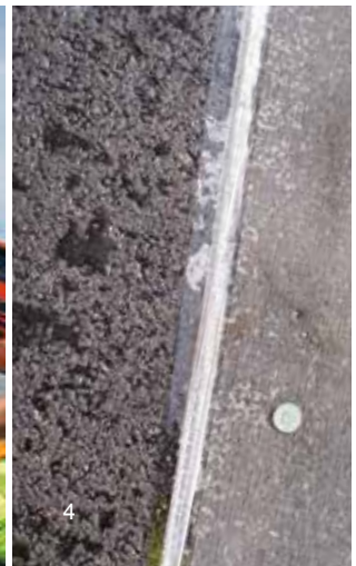
(4) Geomembrana anclada con clavos al antiguo aglomerado asfáltico
