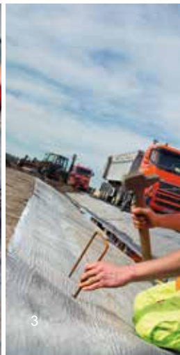
(3) Geomembrana anclada con grapa en la tierra
