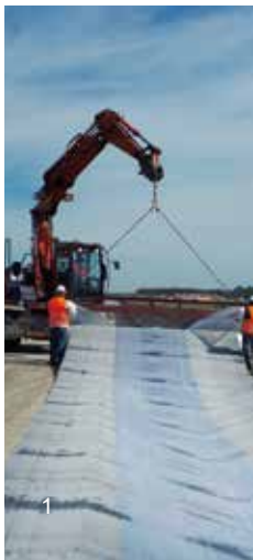
(1) Canuto de acero que facilita el despliegue
