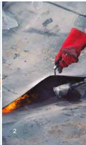
(2) Geomembrana soldada con soplete
