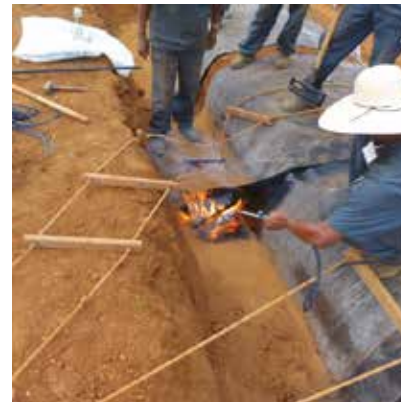
Instalación en una trinchera de anclado.
