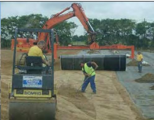
Pelle travaillant en déporté pour permettre une reprise du support juste avant la pose de la géomembrane.
