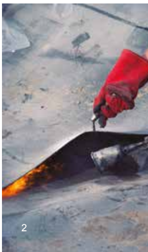
(2) Géomembrane soudée au chalumeau
