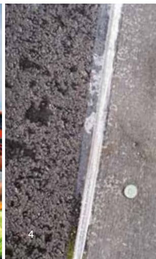
(4) Géomembrane ancrée par clouage dans l'ancien enrobé
