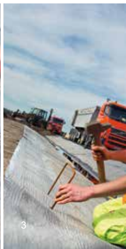
(3) Géomembrane ancrée par agrafe dans la terre
