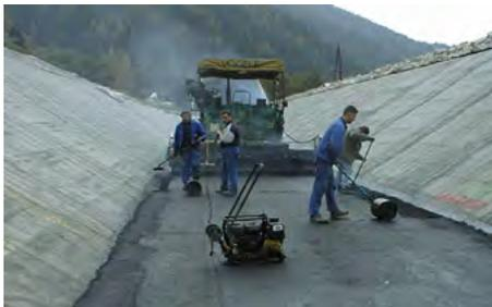
De par sa composition à base de bitume, COLETANCHE® permet de mettre en oeuvre les enrobés directement sur la géomembrane.
