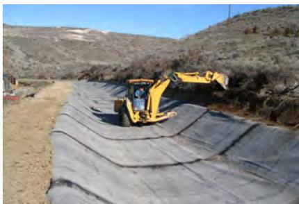
La pliabilité importante du COLETANCHE® permet un ancrage transversal tout le long des canaux pour :
