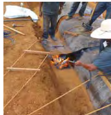
Mise en œuvre dans une tranchée d'ancrage
