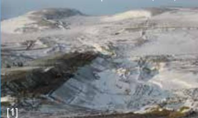
Pose en conditions climatiques extrêmes (+40°C)
