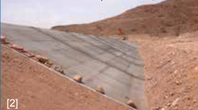
Parement amont de barrage en enrochement avec une pente de 2H:1V.
