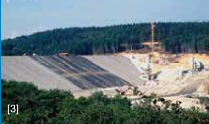
Parement amont de barrage en enrochement avec une pente de 2H:1V.
