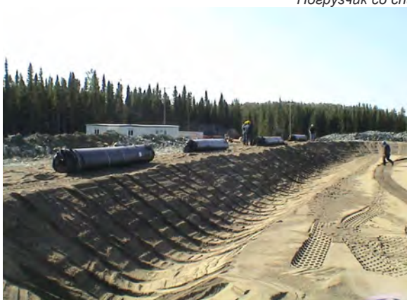
Рулоны лайнера раскладывают в местах планируемой установки так, чтобы их мог захватить бульдозер
