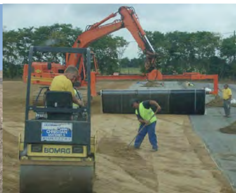
Гидравлическая стойка экскаватора находится на определенном расстоянии для того, чтобы рабочие могли очистить основание вручную перед самым настилем геомембраны.
