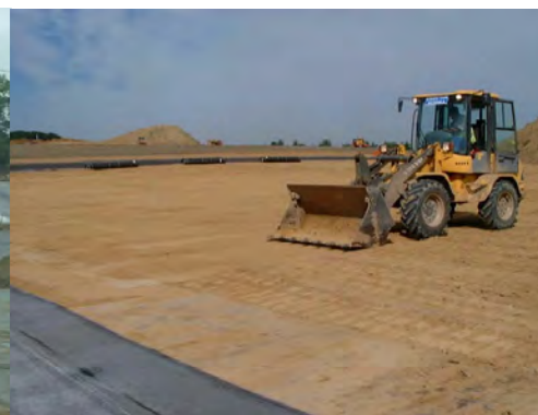
Очистка основания граблями
