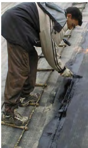
авершение ремонта шва при помощи мастерка
