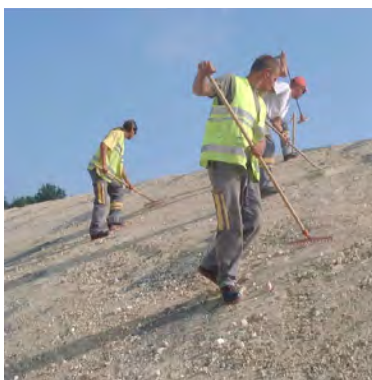
Очистка основания граблями
