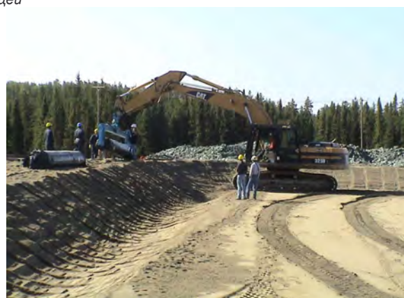
Рулоны лайнера раскладывают в местах планируемой установки так, чтобы их мог захватить бульдозер
