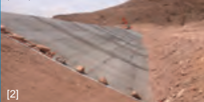
Покрывание внешней стороны каменнотранспортной плотины со склоном 50%.
