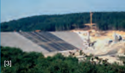
Покрывание внешней стороны каменнотранспортной плотины со склоном 50%.
