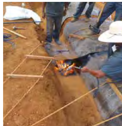
Установка в анкерной траншее
