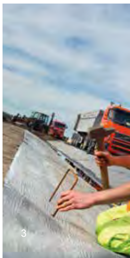
(3) Анкеровка геомембраны скобами в землю
