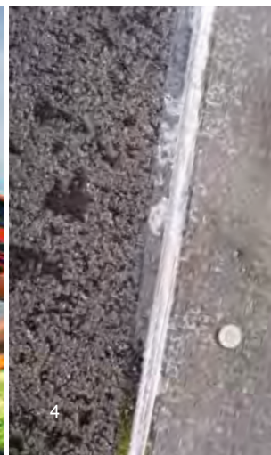
(4) Пришивка гвоздями к асфальтовому покрытию
