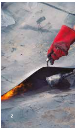
(2) Сварка стыков геомембраны газовой горелкой
