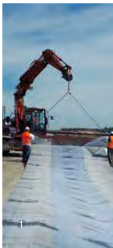
(1) Использование траверсы упрощает размотывание рулона
