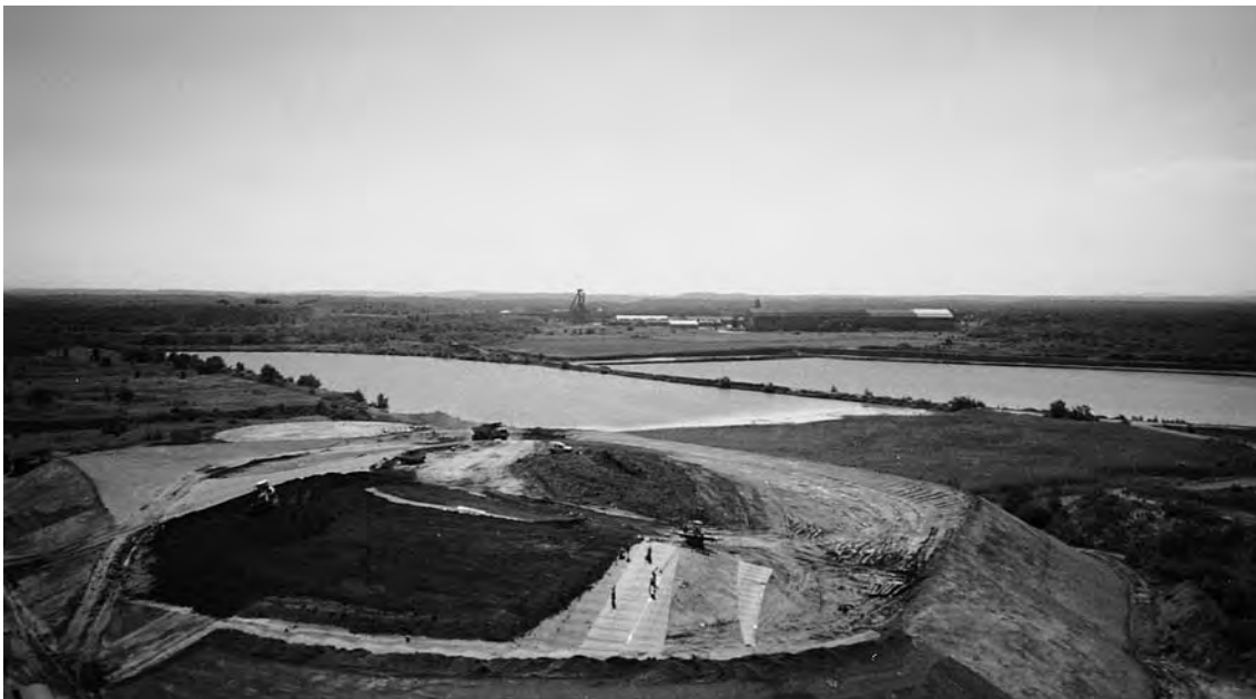
Photo 1 Vue générale du site avec différentes phases du chantier : préparation du support, géotextile, géomembrane, recouvrement en terre / Overview of the site with different phases of the work: preparation of the support, geotextile, geomembrane, covering soil.
